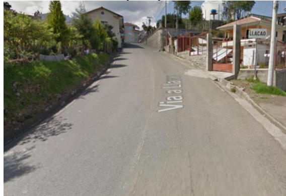
Fotografía 10. Asfaltado Vía Llaqueo - Capulispamba
