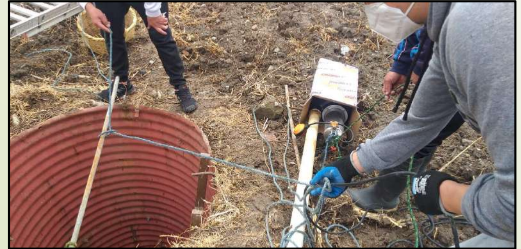
Colocación de bomba en el sector de la Unión
