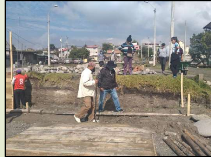
Excavación y encofrado para muro de contención
