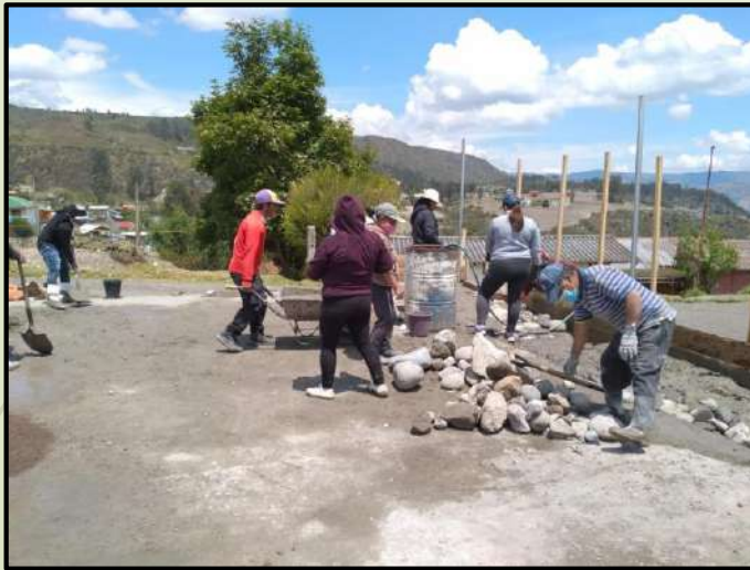
Construcción de muro de contención
