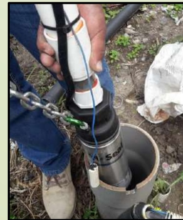
Colocación de bomba en el sector de la Unión
