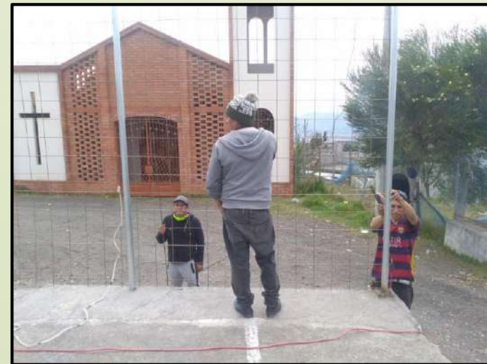
Colocación de postes galvanizados y malla de cerramiento
