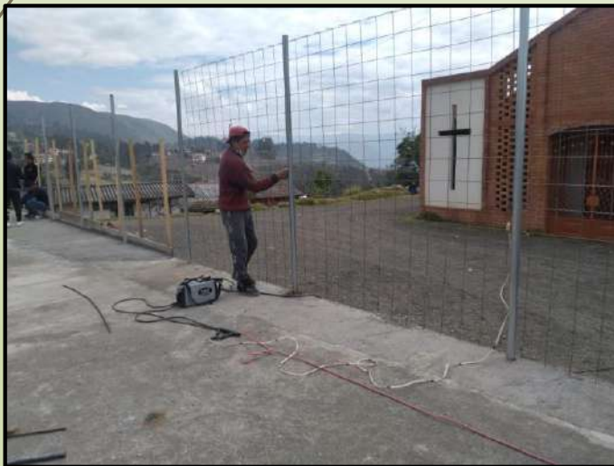
Colocación de postes galvanizados y malla de cerramiento
