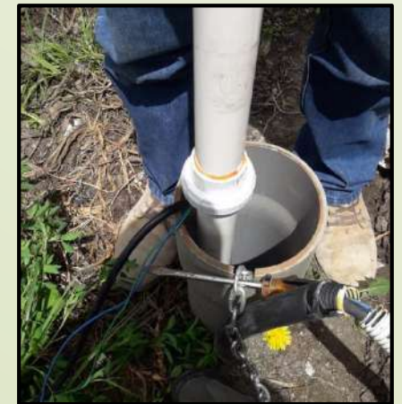
Colocación de bomba en el sector de la Unión
